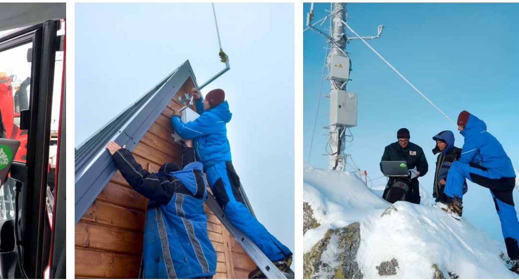
Installation der Funkantenne an außergewöhnlicher Stelle.
