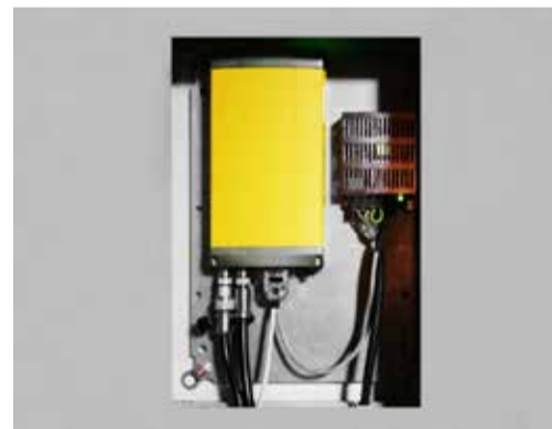
Struttura della stazione base
